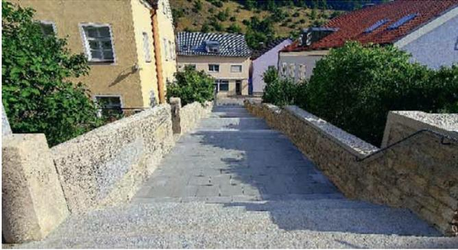
Die Baumaßnahme an den Kirchentreppen ist nach zwischenzeitlicher Umplanung beendet. Der Belag wurde ausgetauscht, die Granitstufen auf neues Niveau gesetzt und die Brüstungsmauern abgestrahlt und gereinigt.
