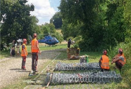
Diese Maßnahme war mit einem erhöhten Mehraufwand durch die exponierte Lage verbunden, da die Maschinerie und sämtliche Tätigkeiten händisch unter großem Aufwand erfolgen müssen. Zudem muss der Fangzaun mittels Helikopter eingeflogen werden. Eine reine Einnetzung weist keine langfristige Stabilität durch den Schwund des Baumes und der Äste auf, da durch Witterungseinflüsse
