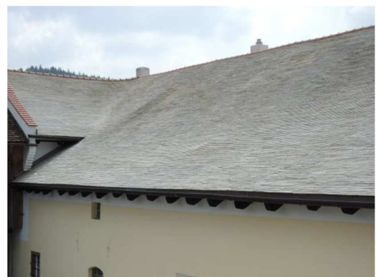
Neues Kalkplattendach mit Kehldeckung
