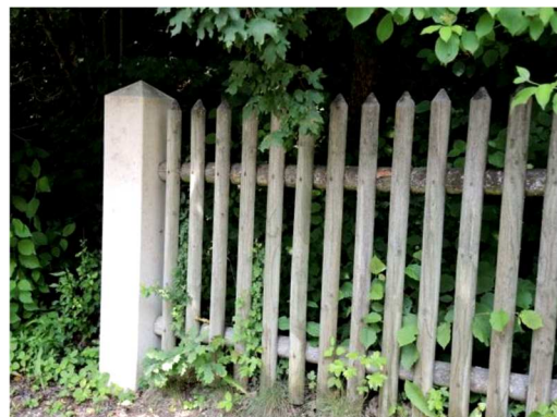
Lattenzaun zwischen Kalksteinsäulen
