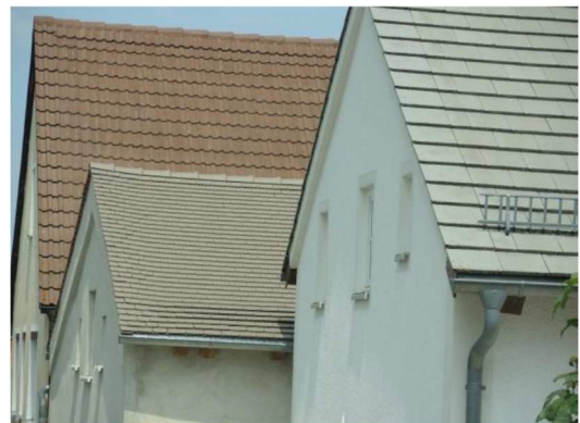
Pfannen- und Gradschnittbiber aus grauem Beton
