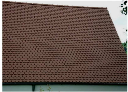
Biberschwanzdoppeldeckung, nicht engobiert
