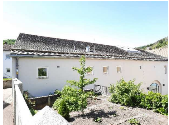
Kein Dachüberstand, Dachrinnen und Fallrohr aus Titanzink
