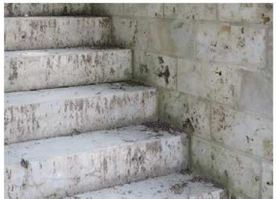
Natursteinaußentreppe und Sockelwandverkleidung
