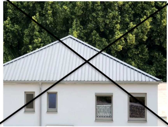
Dach aus Trapezblechen
