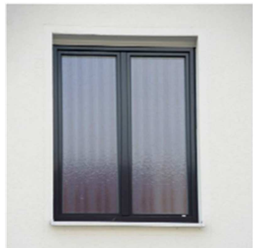
2-flügeliges Fenster, isolierverglast mit Sprossen
