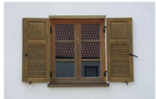
2-flügeliges Fenster, isolierverglast mit Sprossen
