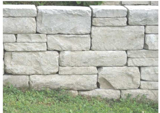
Kalksteinmauerwerk trockenengelegt oder vermörtelt
