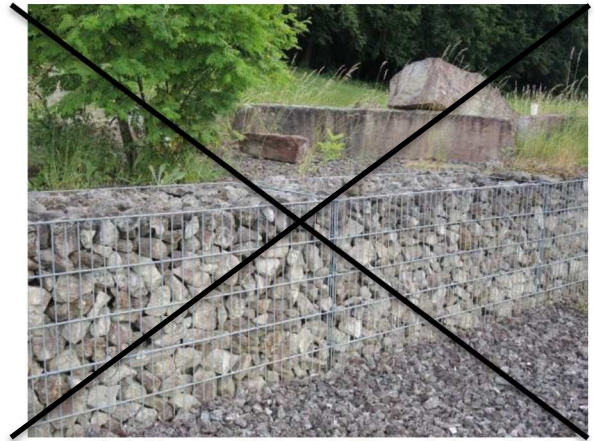
Auch Gabionen mit Natursteinfüllung sind unzulässig
