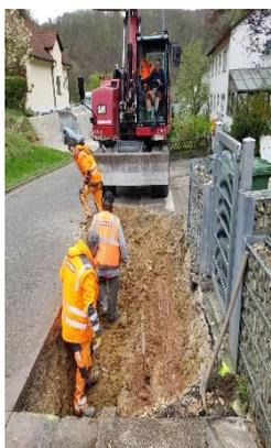
Die **Sanierung des Abwassernetzes** hat begonnen, nach den Arbeiten in der Haunsfelder Straße erfolgt nun die Sanierung schadhafter Rohrsysteme in offener Bauweise in der Altheimer Straße und Frühlingstraße sowie weiteren Ortsstraßen. Oftmals liegt der Kanal sehr tief und die Wasserleitung genau darüber, sodass hier u.a. auch bauliche Erschwernisse vorhanden sind.
