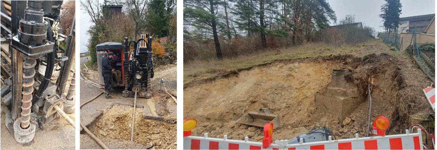
Mittels Bohrgeräten wurde die neue Wasserleitung vom Plattenberg zur unteren Straße gebohrt. In Kürze wird das Drucksteigerungsgebäude aufgestellt und die Anschlüsse hergestellt sowie die Zusammenschlüsse mit der bestehenden Leitung vorgenommen. Im Rahmen dessen werden zusätzlich schadhafte Asphaltstücke im Gemeindebereich mit saniert. Im März wird mit der Baufertigstellung gerechnet. Die Anwohner werden gebeten, Druckminderer installieren zu lassen.
