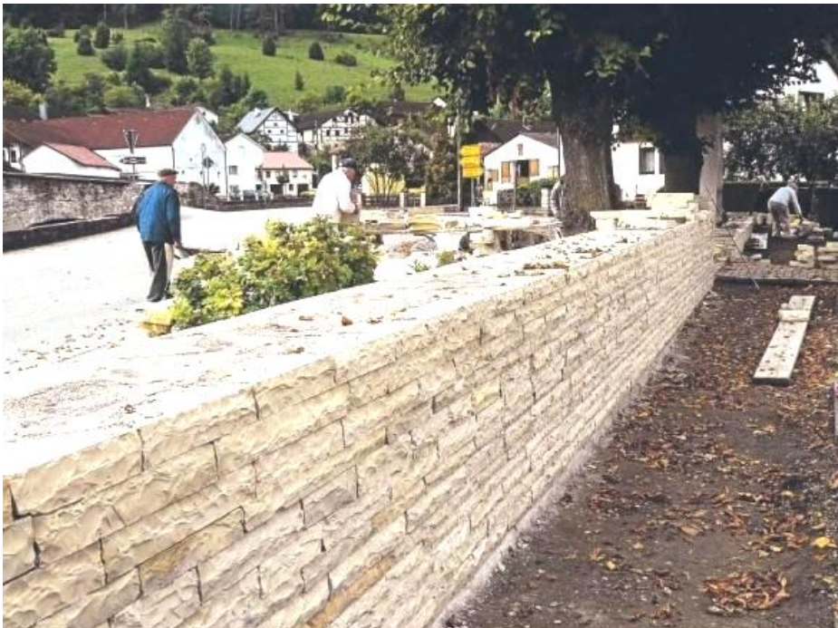
Die Friedhofsmauer in Mühlheim wurde in traditioneller Handwerksmanier hochgezogen. - Foto: oh
