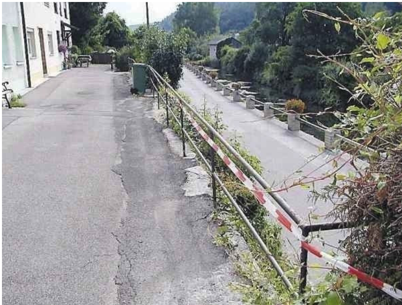
Bild: Auf einer Länge von 52 Metern soll das Stahlrohrgeländer an der Kreisstraße ersetzt werden. - Foto: mi
