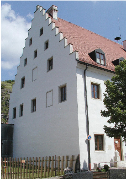
Bild: Der Kastenhof in Mörnsheim soll ebenso wie alle anderen Häuser in Gemeindebesitz einen Energieausweis erhalten. - Foto: mdl
