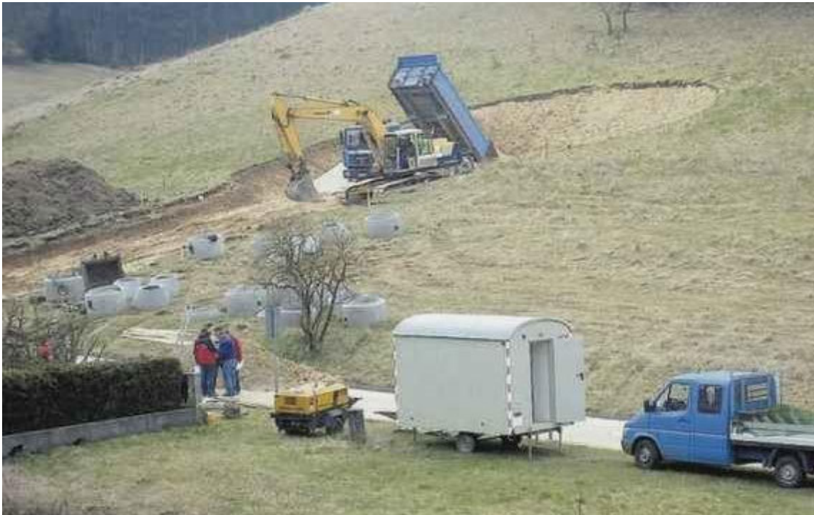
Schreitet voran: die Erschließung des Baugebiets „Am Bremberg II“
