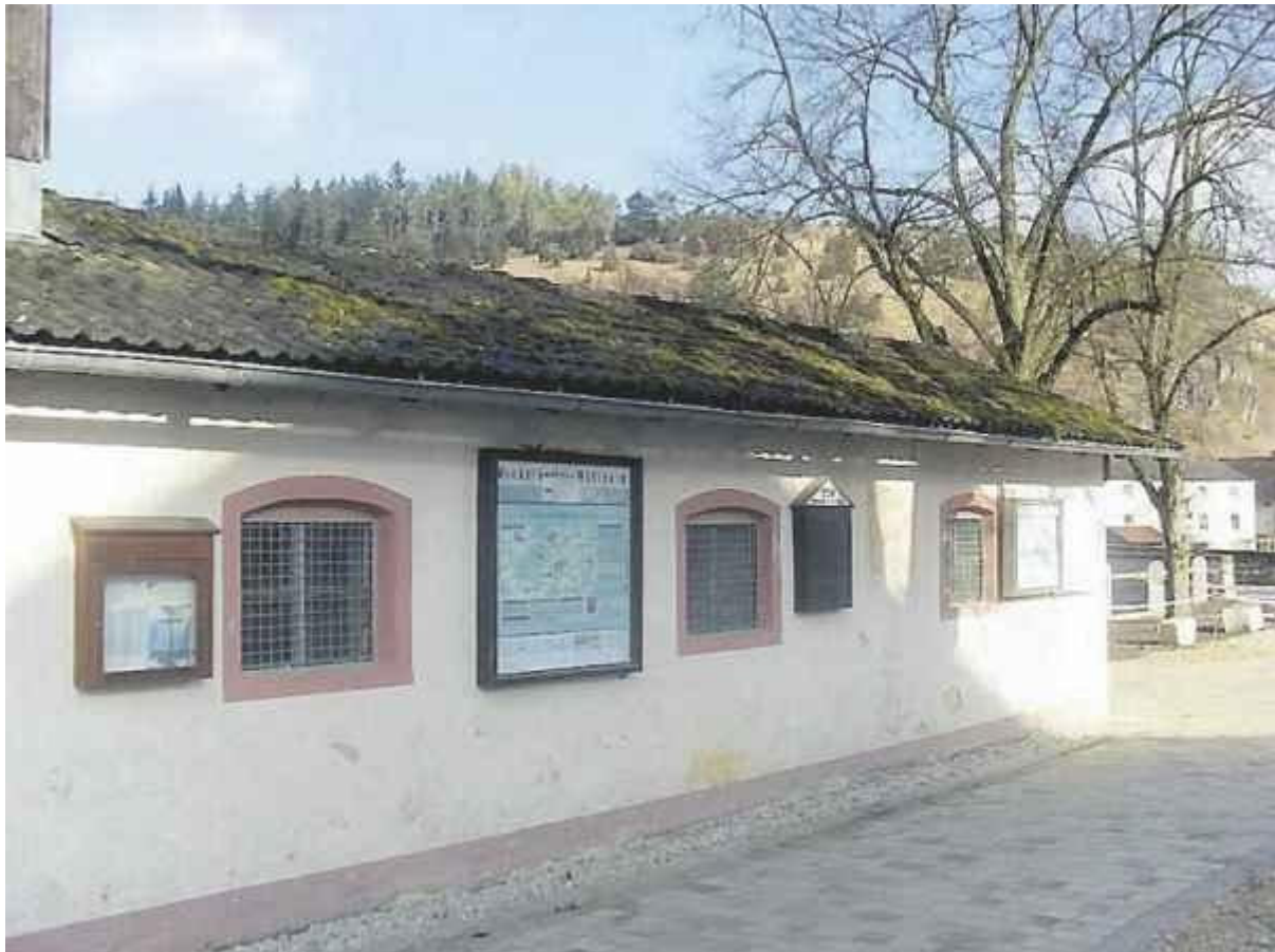
Bild: Das ehemalige Feuerwehrhaus wird gerade saniert. - Foto: mdl
