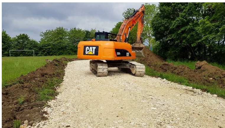
Die Bagger sind angerollt am Sportplatz in Ensfeld, wo der Holzlagerplatz erweitert wird. Durch die Erhöhung der Kapazität soll auch dem Borkenkäfer Einhalt geboten werden.
