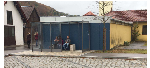
Ein Ziel des Nahverkehrsplans des Landkreises Eichstätt ist Barrierefreiheit an allen Haltestellen. Da in Mörnshiem sämtliche Haltestellen an der Kreisstraße liegen, müssen gemeinsame Lösungen mit dem Landkreis gefunden werden. Foto: Eberle
