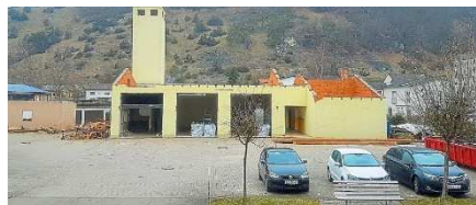
Nach Ostern wird das Feuerwehrhaus in Mörnshiem komplett abgerissen. Im Mai beginnen die Arbeiten zum Neubau. Foto: Geiger
