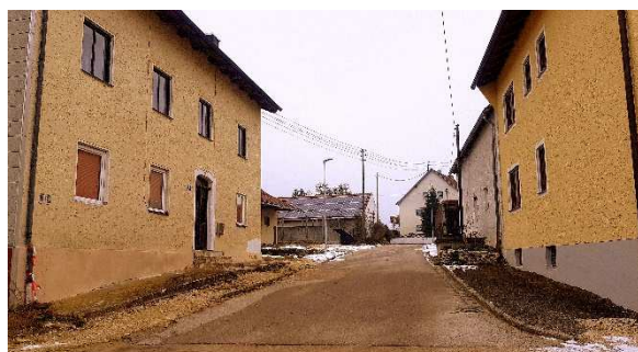
Der Marktgemeinderat Mörnsheim hat in seiner jüngsten Sitzung weitere Straßenbauarbeiten im Ortsteil Ensfeld vergeben. Hierbei wird die ehemalige Milchsammelstelle sowie der zum Baugebiet dazugehörige Gehweg saniert. Foto: Geiger
