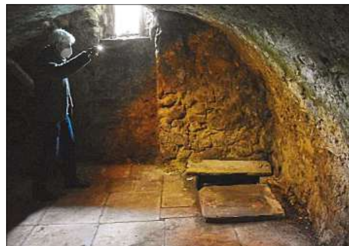
Eine Besonderheit: Der Hausbrunnen im Kellerboden führt immer noch Wasser.
