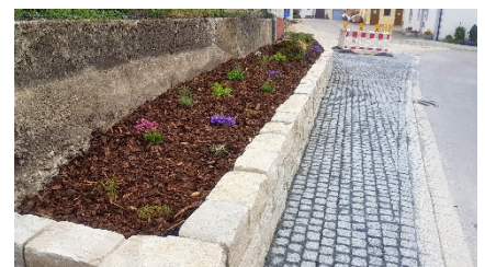
Baufortschritte der Straßenbauarbeiten der Dorferneuerung in Ensfeld: Am neuen Dorfplatz wurden hinter der Mauer aus Natursteinen Anpflanzungen vorgenommen. Es fehlen noch die Brunnenmauer und Sitzbänke. Foto: Geiger
