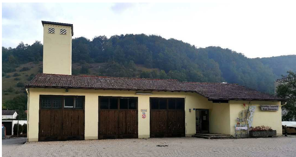
Für den Neubau des Feuerwehrgerätehauses in Mörsnheim wurde das Konzept und die Planung durch das Planungsbüro Hajek aus Mörsnheim vorgestellt. Im Bild das Gebäude aus den 1960er-Jahren.
