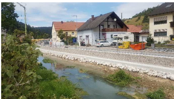
Die Baumaßnahmen liegen im Zeitplan: In Mühlheim wird im zweiten Abschnitt die Ufermauer von der Gailachbrücke bis zum Ortseingang erneuert. Foto: Sabrina Geiger
