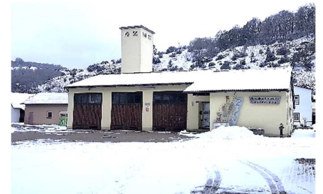
Die Werkplanung für das neue Feuerwehrgerätehaus ist beschlossen. Nunmehr erfolgen die Ausschreibungen für die entsprechenden Gewerke. Foto: Geiger
