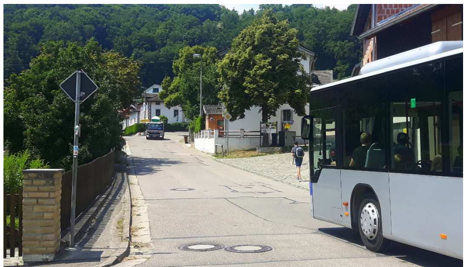
Bürgermeister Mittl informierte die Marktgemeinderäte über die Planungen des Neubaus eines Gehwegs an der Kreisstraße in Mörnsheim. Dadurch kann vor allem die Sicherheit der Fußgänger erhöht werden, die bis jetzt auf der Fahrbahn unterwegs sind. Foto: Eberle
