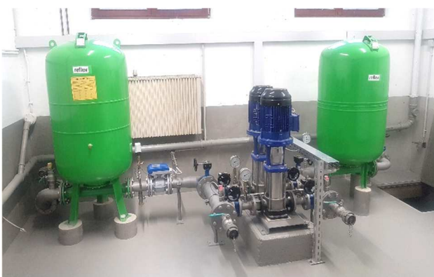
Durch die umfangreiche Sanierung der Wasserversorgungsanlagen in den vergangenen Jahren erhöhen sich nun die Wasserverbrauchsgebühren. Im Bild die neue Druckerhöhungsanlage für Haunsfeld. Foto: Geiger
