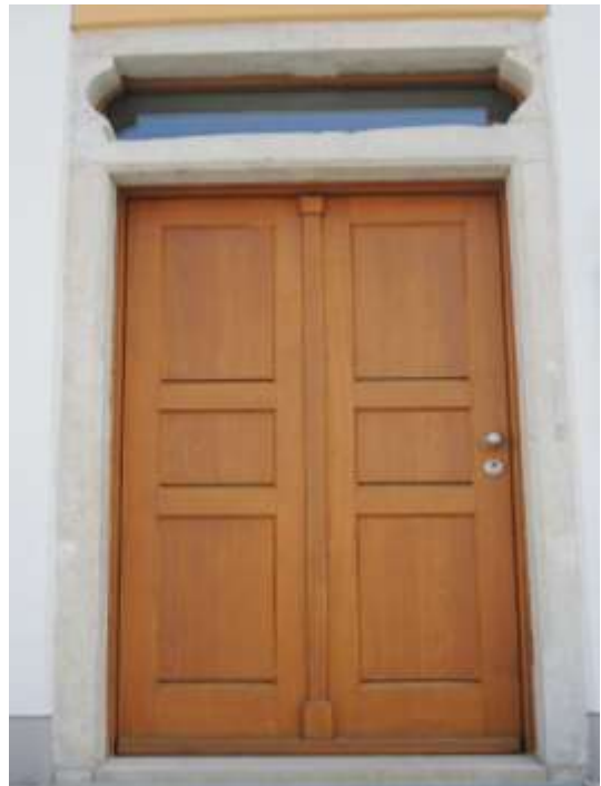
Neues Türblatt in bestehendem Gewände
