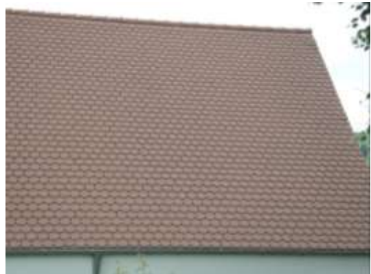
Biberschwanzdoppeldeckung, nicht engobiert
