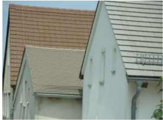
Pfannen- und Gradschnittbiber aus grauem Beton
