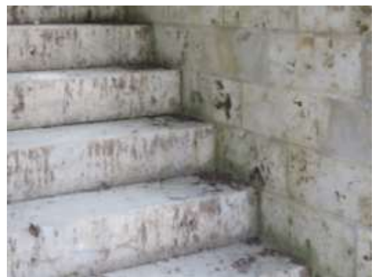
Natursteinaußentreppe und Sockelwandverkleidung
