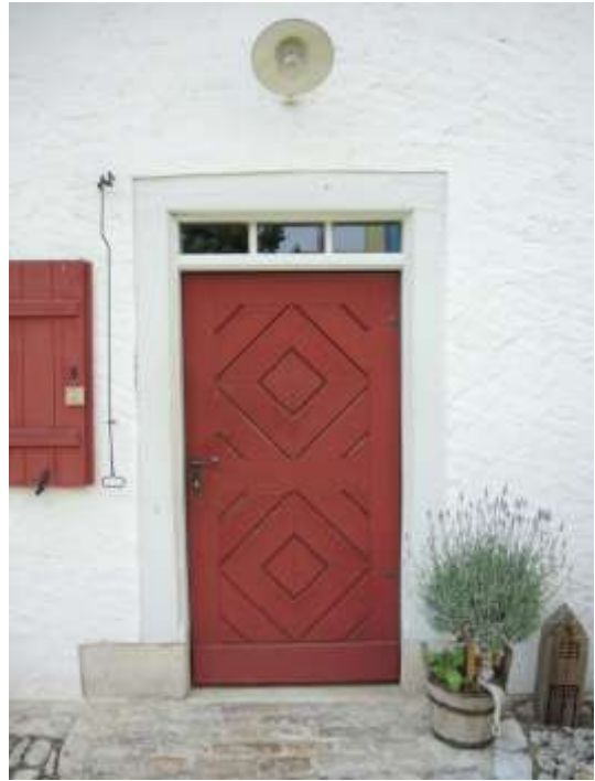
Restaurierte und ergänzt Außentüre an einem Jurahaus
