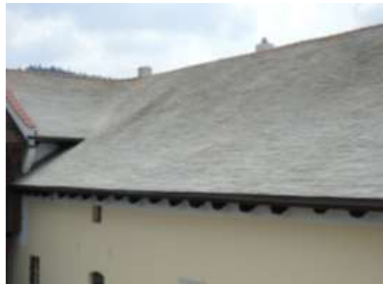
Neues Kalkplattendach mit Kehldeckung
