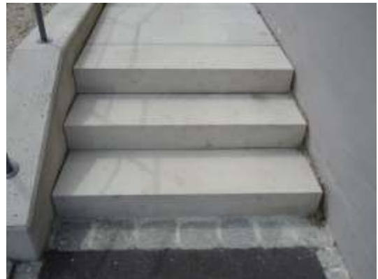
Kalksteinstufen und Gehbelag
